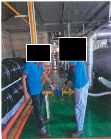
ฝ่ายซ่อมบำรุงทำการปิดวาล์วก๊าซฉุกเฉินที่อยู่บริเวณสถานีก๊าซ
