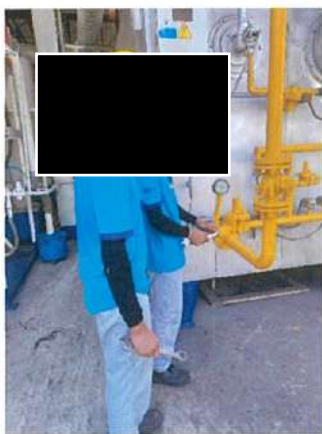
ฝ่ายซ่อมบำรุงทำการปิดวาล์วก๊าซฉุกเฉินที่อยู่บริเวณจุดเกิดเหตุ
