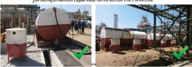
รูปตัวอย่างอุปกรณ์ที่เก็บกับ Liquid waste และหน่วยบำบัด VOCs ที่เหมาะสม
