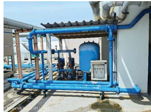
บูสเตอร์ปั๊มรักษาแรงดันในการจ่ายน้ำใช้
