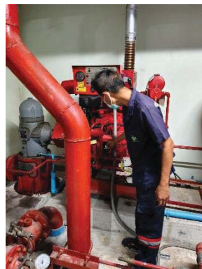
ตรวจสอบปั๊มสูบน้ำดับเพลิง
