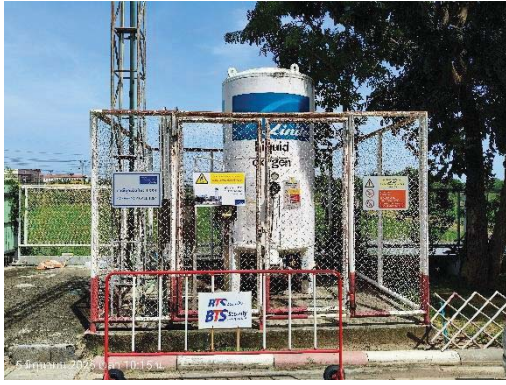
ภาพที่ 2-23 ระบบจ่ายก๊าซภายในโรงพยาบาล
