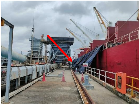
ภาพที่ 2-7 ผ้าใบคลุมช่องว่างระหว่างหน้าท่ากับเรือ ขณะดำเนินการขนถ่ายถ่านหิน
