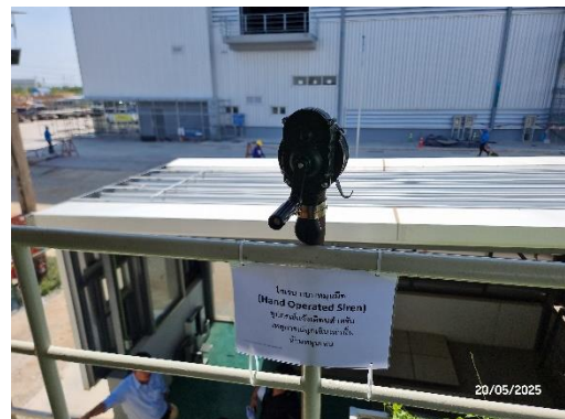
รูปที่ 2-38 สัญญาณเตือนภัยแบบมือหมุน
