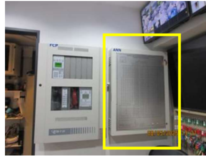
แผงแสดงสัญญาณ (Graphic Board Annunciator)
