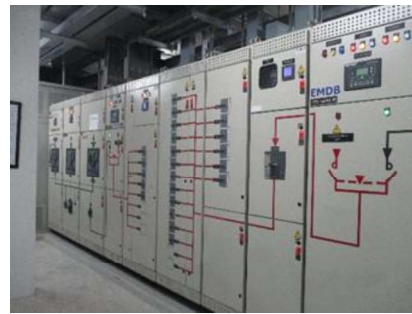
ภาพที่ 2.2-30 เครื่อง Circuit Breaker
