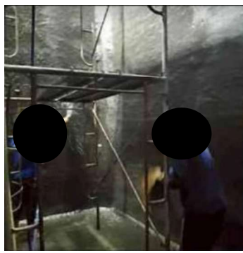
ภาพที่ 2.2-13 ล้างทำความสะอาดถังเก็บน้ำใต้ดิน
