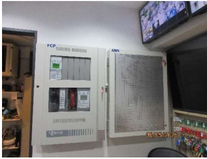
แผงควบคุมรวมระบุดำหน่ง (Fire Alarm Control Panel : FCP)
