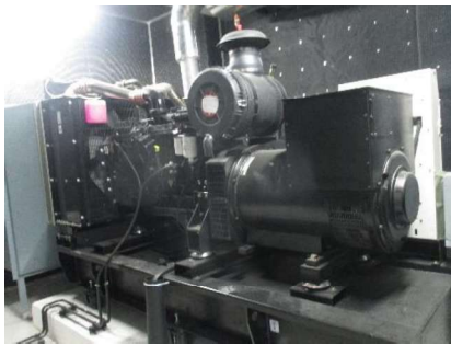
ภาพที่ 2.2-29 เครื่องกำเนิดไฟฟ้าสำรอง ขนาด 350 KVA
