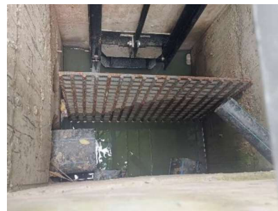
ภาพที่ 2.2-22 ตะแกรงดักมูลฝอยบริเวณจุดระบายน้ำออกจากที่ระบายน้ำ
