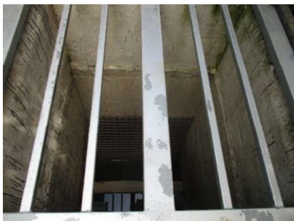
ภาพที่ 2.2-22 ตะแกรงดักมูลฝอยบริเวณจุดระบายน้ำออกจากที่ระบายน้ำ
