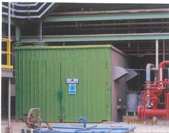
รูปที่ 3.1-1 การติดตั้ง Noise Absorber ให้กับเครื่องจักรที่มีเสียงดัง
