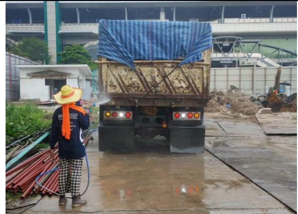
รูปที่ 26 พื้นที่ล้างล้อรถของโครงการ
