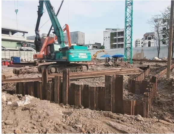
รูปที่ 63 การลง Sheet pile
