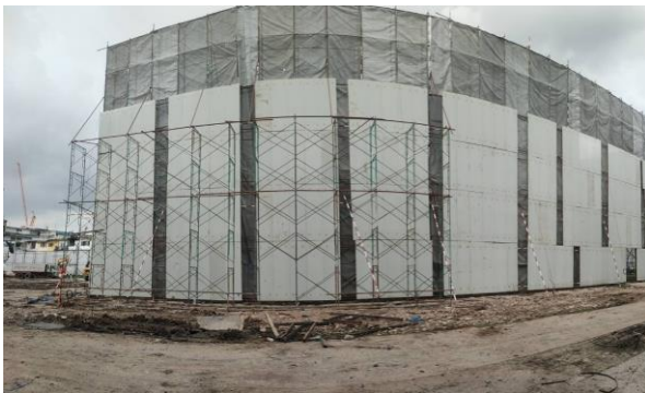
รูปที่ 11 Mesh Sheet กันฝุ่น / กำแพงกันเสียง เคลื่อนที่ ในระหว่างที่มีการรื้อถอนอาคารเดิม
