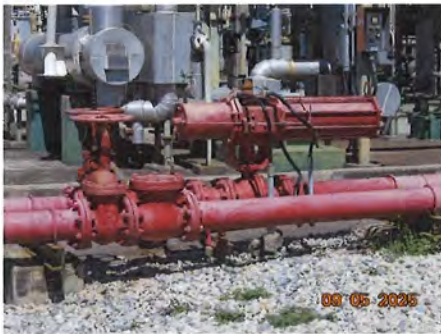
ภาพที่ 2-15 Interlock Valve
