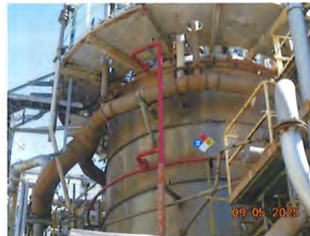
ภาพที่ 2-18 ระบบฉีดน้ำภายนอกถังปฏิกรณ์
