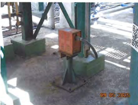
ภาพที่ 2-24 Gas Detector
