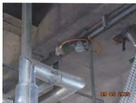
ภาพที่ 2-25 Heat Detector
