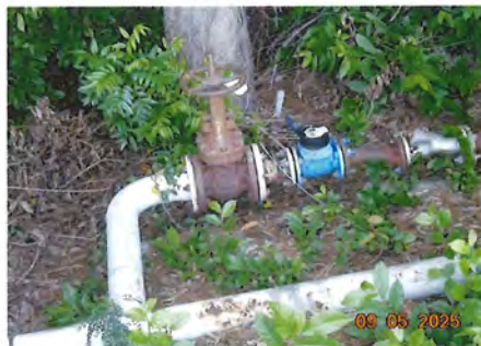
ภาพที่ 2-4 ท่อน้ำเสียที่ส่งไปบำบัดยัง บริษัท พีทีที โกลบอล เคมิคอล จำกัด (มหาชน)
