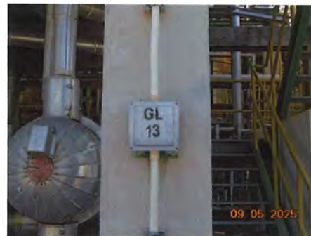
ภาพที่ 2-21 ระบบป้องกันฟ้าผ่าและระบบสายดิน
