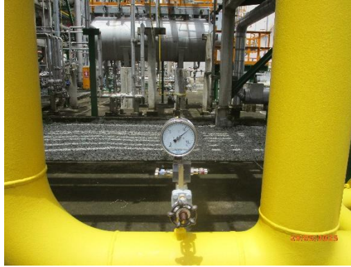
รูปที่ 3.55 Pressure / Temperature Indicator
