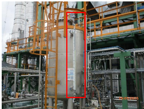
รูปที่ 3.52 Level Indicator ที่ถังเก็บกัก
