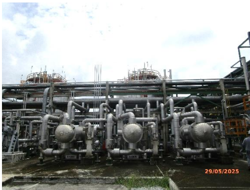
รูปที่ 3.58 ฉนวนหุ้มอุปกรณ์การผลิต ที่เกี่ยวข้องกับโพธิ์หินออกไซด์
