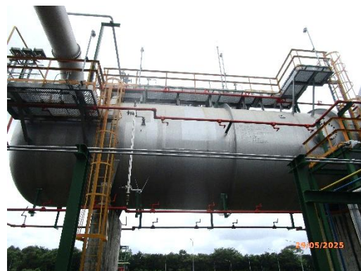
รูปที่ 3.42 ระบบน้ำฉีด (Water Spray) รอบผนังและหลังคาถังเก็บ
