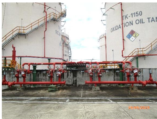
รูปที่ 3.42 ระบบน้ำฉีด (Water Spray) รอบผนังและหลังคาถังเก็บ
