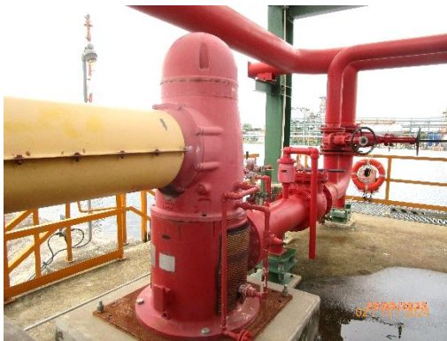
รูปที่ 3.49 เครื่องสูบน้ำดับเพลิง
