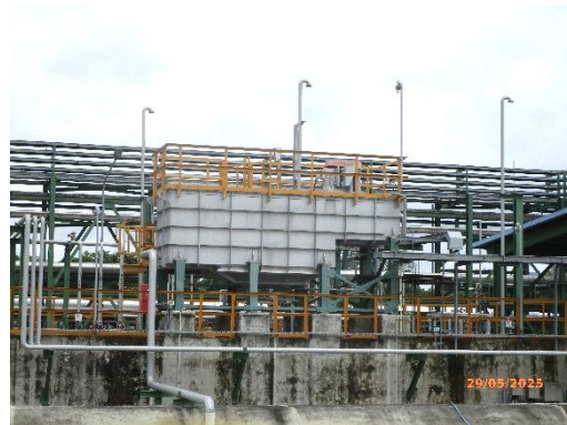
บ่อแยกน้ำมันและของแข็งแขวนลอย (Oil Separation/Suspended Solid Separation)
