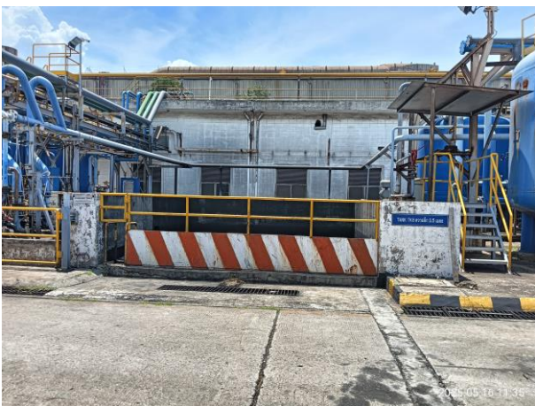
รูปที่ 3-32 ป่อเก็บรวบรวมน้ำจาก Sludge เพื่อส่งไปยัง Irrigation Pond และนำกลับมาหมุนเวียนใช้ใหม่
