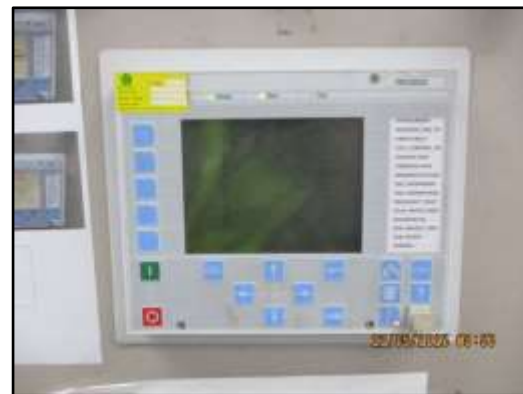
ภาพที่ 2.50 อุปกรณ์ป้องกันกระแสเกิน (Over current relays), อุปกรณ์ป้องกันแรงดันไฟฟ้าสูงเกิน (Over voltage relay), อุปกรณ์ป้องกันไฟฟ้าย้อนกลับ (Reverse power relay), อุปกรณ์ป้องกันการรั่วไหลของแรงดันไฟฟ้า (Ground over voltage relay)
