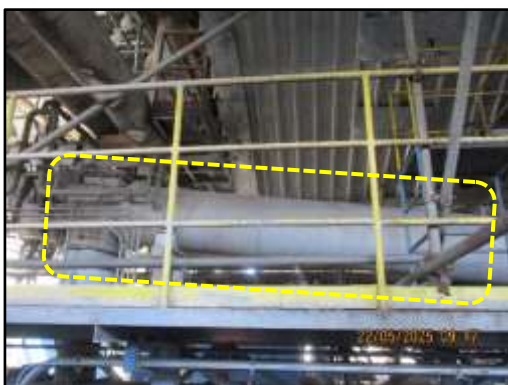
ภาพที่ 2.11 ระบบลำเลียงเถ้ามายังไซโลเก็บเถ้าแบบระบบปิด
