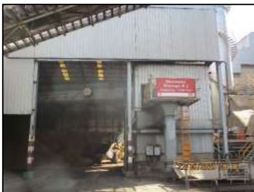
ภาพที่ 2.6 พื้นที่กองเก็บเชื้อเพลิง มีผนังกันลมหรือสิ่งกีดขวางทางลม
