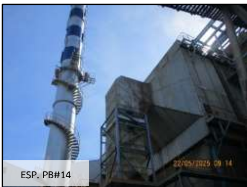
ภาพที่ 2.10 ระบบบำบัดมลพิษทางอากาศของหม้อไอน้ำแต่ละชุด
