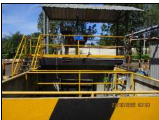
ภาพที่ 2.29 ประตูระบายน้ำฝน และเครื่องมือตรวจวัดคุณภาพน้ำอย่างต่อเนื่อง (Online)
