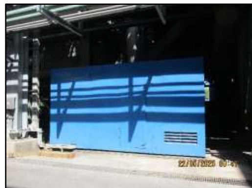
ภาพที่ 3.75 การปิดครอบเครื่องจักรอุปกรณ์ที่มีเสียงดัง
