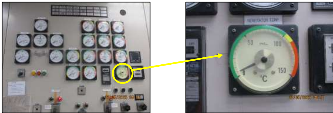
ภาพที่ 2.51 อุปกรณ์วัดอุณหภูมิของขดลวด (Temperature indicator for stator coils)
