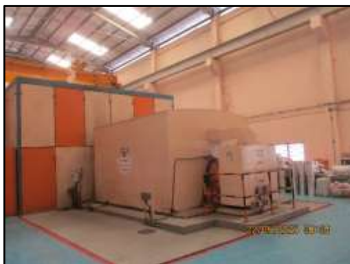
ภาพที่ 3.75 การปิดครอบเครื่องจักรอุปกรณ์ที่มีเสียงดัง
