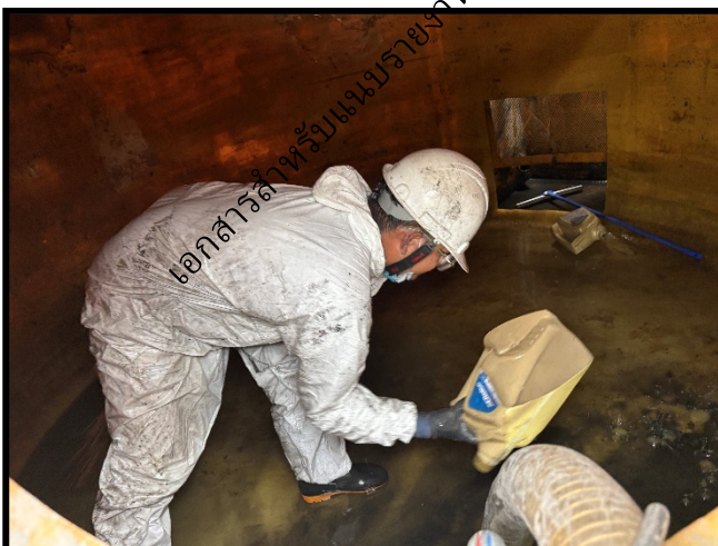
ภาพชุดที่ 6 ดูดน้ำกันถัง นีคล้างทำความสะอาด และตักตะกอนใส่ถังที่ทาง บริษัท สยามคูโบต้า เมททัลเทคโนโลยี จำกัด จัดเตรียมไว้ให้
