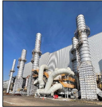
ภาพที่ 2.60 ระบบบำบัดมลพิษทางกลิ่นและระบบบำบัดมลพิษทางอากาศ แบบ Wet Scrubber และ Activated Carbon
