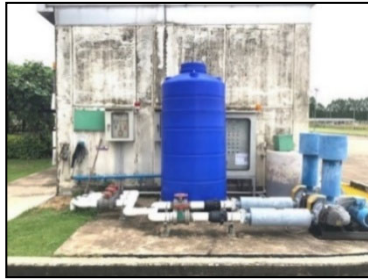
ภาพที่ 2.12 ถังเอนไซม์ เพื่อย่อยไขมันในระบบบำบัด และปั๊มเติมอากาศ
