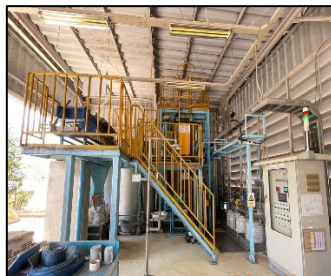
ภาพที่ 2.14 ระบบบำบัดน้ำเสียแบบตกตะกอนทางเคมี
