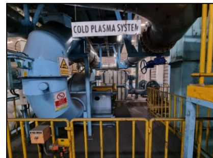
ภาพที่ 2.45 ระบบบำบัดกลิ่นแบบพลาสมาเย็น (Cold Plasma)
