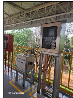
ภาพที่ 2.61 ระบบบำบัดน้ำเสียเพิ่มเติม ชนิดเมมเบรน (Membrane Bio Reactor) เพื่อรองรับน้ำเสียจากระบบบำบัดกลิ่นและรองรับน้ำทิ้งจากระบบบำบัดทางชีวภาพ และระบบบำบัดทางเคมี
