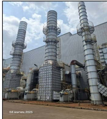
ภาพที่ 2.1 ระบบบำบัดมลพิษทางอากาศ(ระบบดักฝุ่นแบบถุงกรอง Bag Filler)
