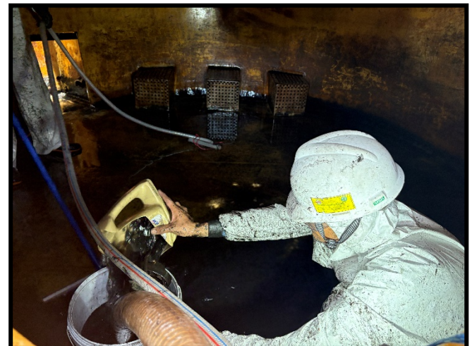
ภาพชุดที่ 6 ดูดน้ำกันถัง นีคล้างทำความสะอาด และตักตะกอนใส่ถังที่ทาง บริษัท สยามคูโบต้า เมททัลเทคโนโลยี จำกัด จัดเตรียมไว้ให้
