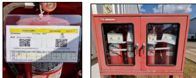
ภาพที่ 2.41 ระบบตรวจสอบและบำรุงรักษาอุปกรณ์ดับเพลิงผ่านระบบ E-form
