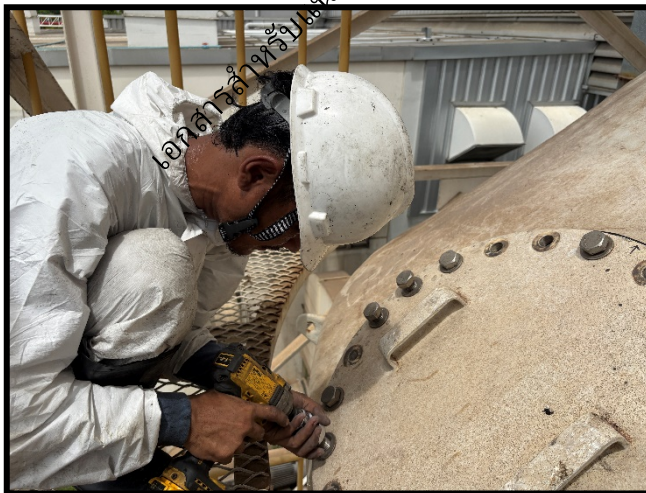
ภาพชุดที่ 8 แจ้งเจ้าหน้าที่ควบคุมงานตรวจสอบก่อนทำการปิดฝาแมนโฮล
