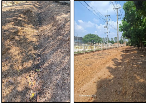
ภาพที่ 2.19 รวดดินระบายน้ำของโครงการ
