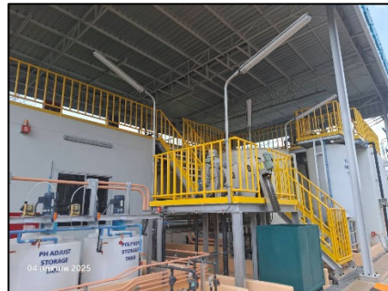
ภาพที่ 2.61 ระบบบำบัดน้ำเสียเพิ่มเติม ชนิดเมมเบรน (Membrane Bio Reactor) เพื่อรองรับน้ำเสียจากระบบบำบัดกลิ่นและรองรับน้ำทิ้งจากระบบบำบัดทางชีวภาพ และระบบบำบัดทางเคมี
