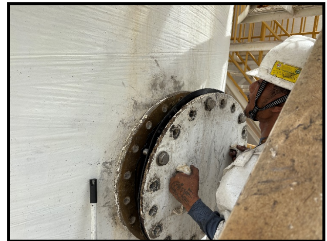
ภาพชุดที่ 8 แจ้งเจ้าหน้าที่ควบคุมงานตรวจสอบก่อนทำการปิดฝาแมนโฮล
