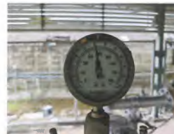
รูปมาตรวัดแรงดันหลังออกจากอุปกรณ์ปรับลดแรงดัน
