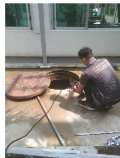
รูปที่ 2-48 สืบตะกอนส่วนเกินและตะกอนหนักในระบบบำบัดน้ำเสีย ปี 2568
