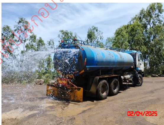
รูปที่ 13 การฉีดพรมน้ำบริเวณเส้นทางขนส่งแร่
