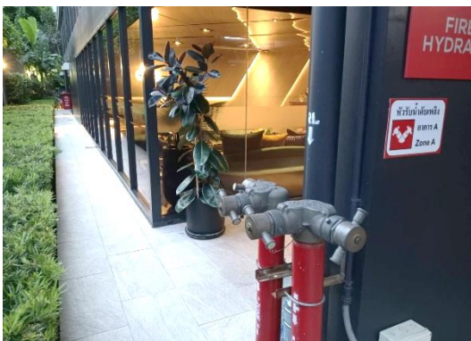
ภาพที่ 30 หัวรับน้ำดับเพลิงภายนอกอาคาร (Fire Department Connector FDC)
