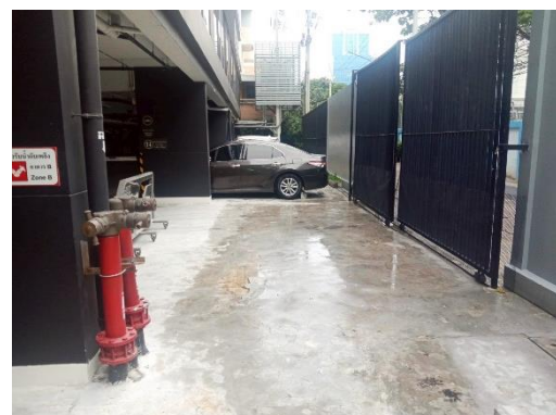
ภาพที่ 30 หัวรับน้ำดับเพลิงภายนอกอาคาร (Fire Department Connector FDC)
