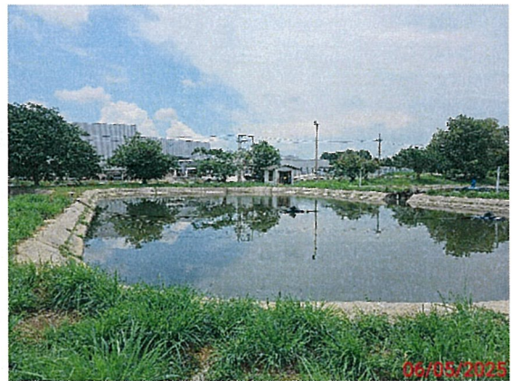
บ่อปรับสภาพน้ำเสีย (Equalization Pond)
