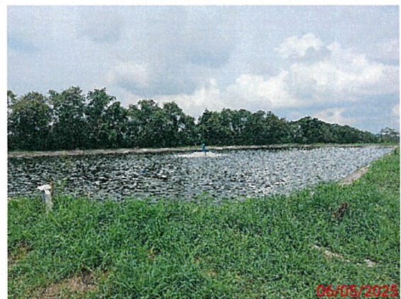
บ่อเติมอากาศ 2 (Aerated Lagoon 2)
