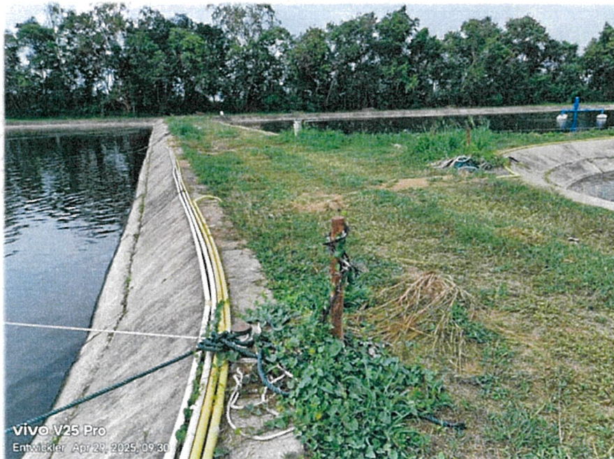
ทำการร้อยท่อเดินสายไฟจากตู้ควบคุมไปยังเครื่องเติมอากาศในบ่อ AT-2
