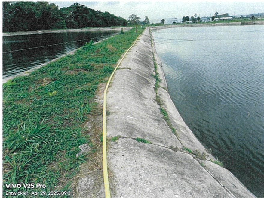
ทำการร้อยท่อเดินสายไฟจากตู้ควบคุมไปยังเครื่องเติมอากาศในบ่อ AT-3
