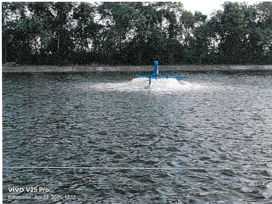
ภาพที่ 3 ติดตั้งเครื่องเติมอากาศขนาด 10 Hp จำนวน 1 ตัว ในบ่อเติมอากาศที่ 2
