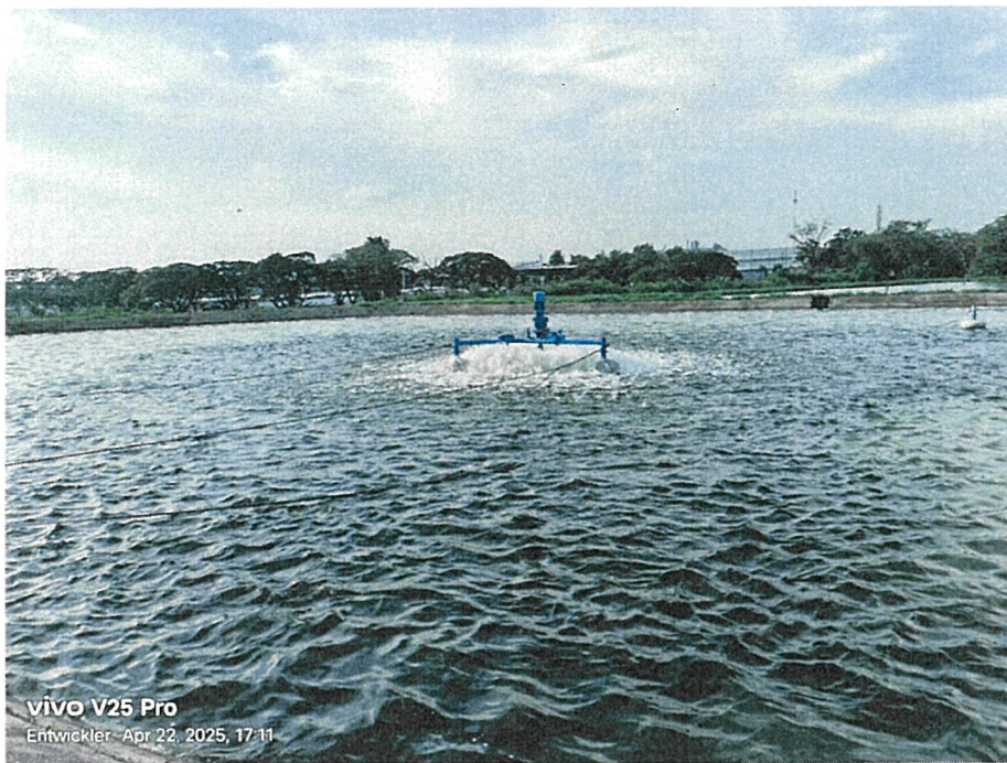
ภาพที่ 3 ติดตั้งเครื่องเติมอากาศขนาด 10 Hp จำนวน 1 ตัว ในบ่อเติมอากาศที่ 3
