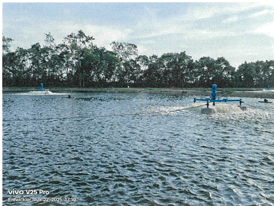
ภาพที่ 1 ติดตั้งเครื่องเติมอากาศขนาด 20 Hp จำนวน 2 ตัว ในบ่อเติมอากาศที่ 1
