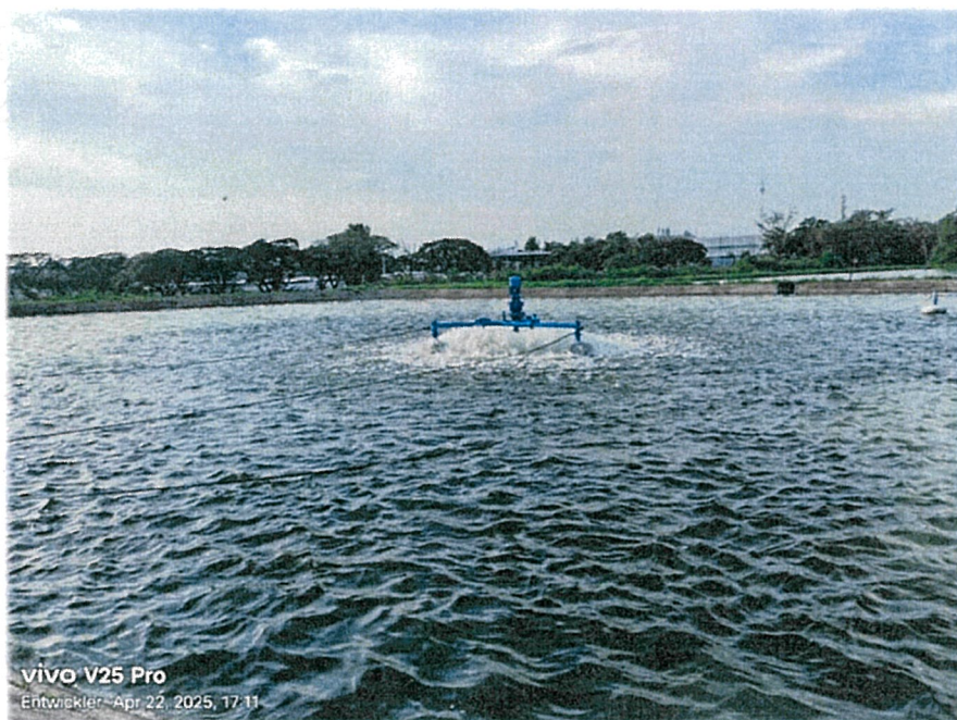
ทำการประกอบโครงสร้างเครื่องเติมอากาศและนำไปติดตั้งในบ่อ AT-3
