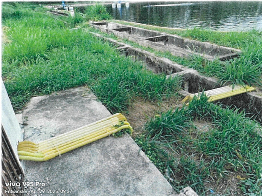
ทำการร้อยท่อเดินสายไฟจากตู้ควบคุมไปยังเครื่องเติมอากาศในแต่ละบ่อ
