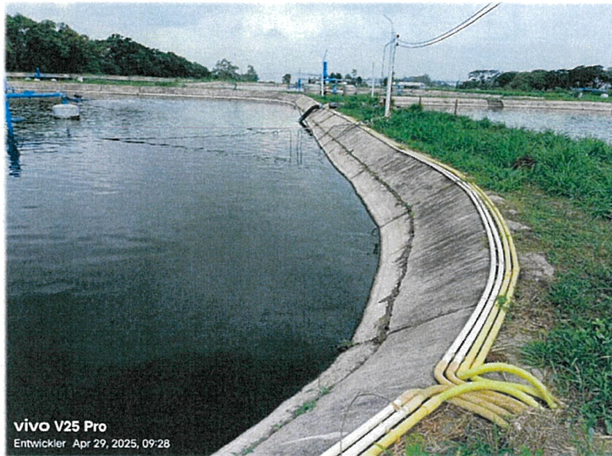
ทำการร้อยท่อเดินสายไฟจากตู้ควบคุมไปยังเครื่องเติมอากาศในบ่อ AT-2 และ AT-3
