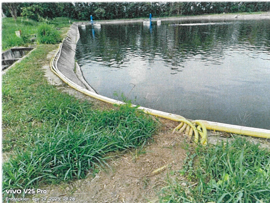
ทำการร้อยท่อเดินสายไฟจากตู้ควบคุมไปยังเครื่องเติมอากาศในบ่อ AT-1
