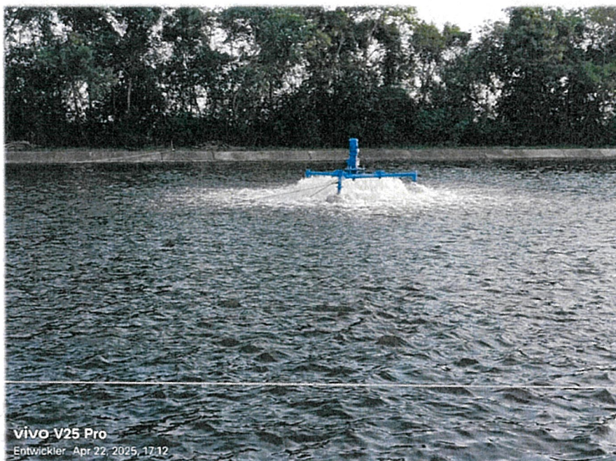
ทำการประกอบโครงสร้างเครื่องเติมอากาศและนำไปติดตั้งในบ่อ AT-2
