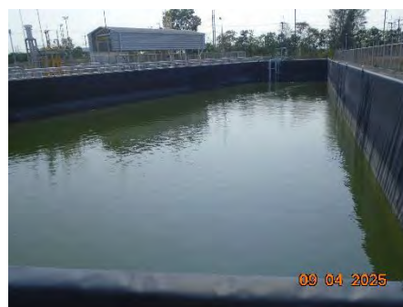
ภาพที่ 2-17 บ่อหน่วงน้ำภายในพื้นที่โครงการ
