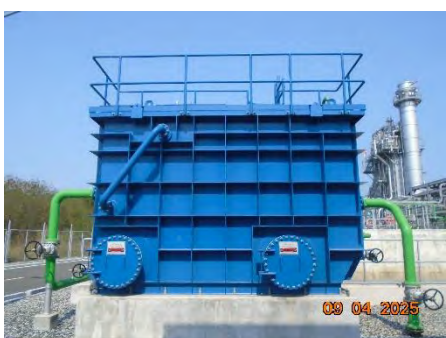
ระบบแยกน้ำ-น้ำมัน (Oil Water Separated)
