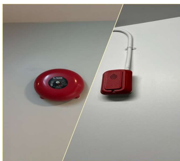
รูปที่ 2.4.8-6 กริ่งสัญญาณเตือนภัย
