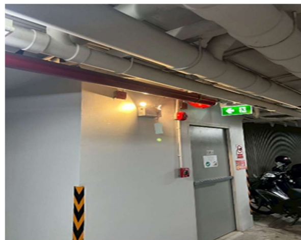
รูปที่ 2.4.8-9 ไฟส่องสว่างฉุกเฉิน
