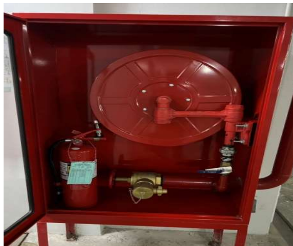
รูปที่ 2.4.8-4 ตู้เก็บสายน้ำดับเพลิงพร้อมอุปกรณ์
