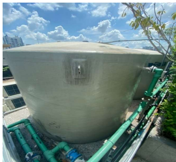
รูปที่ 2.4.2-2 ถังเก็บน้ำชั้นดาดฟ้า
