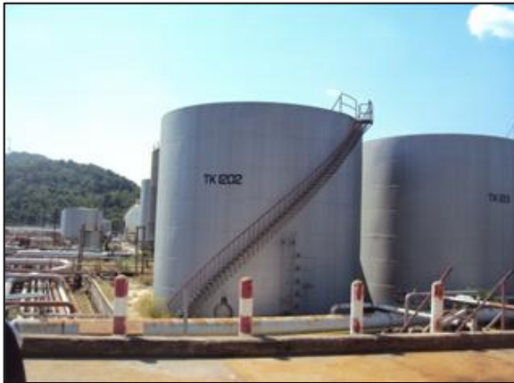
รูปที่ 2-7 Slop Tank รับน้ำเสียปนเปื้อนน้ำมัน
