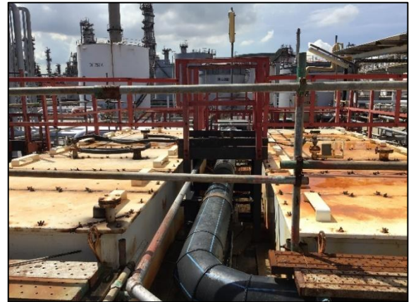
รูปที่ 2-8 ระบบ API Separator
