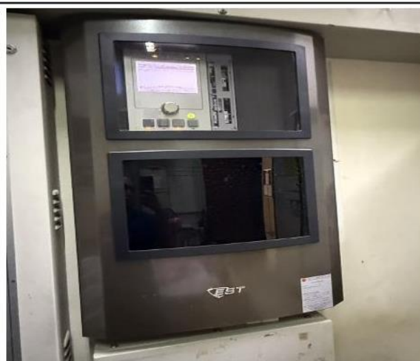
ภาพที่ 30 Fire Alarm Control Panel
