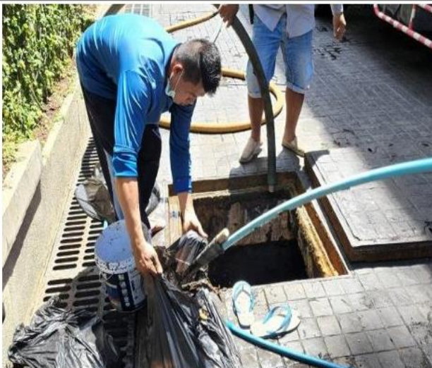
ภาพที่ 11 สูดตะกอนและตักกาก
