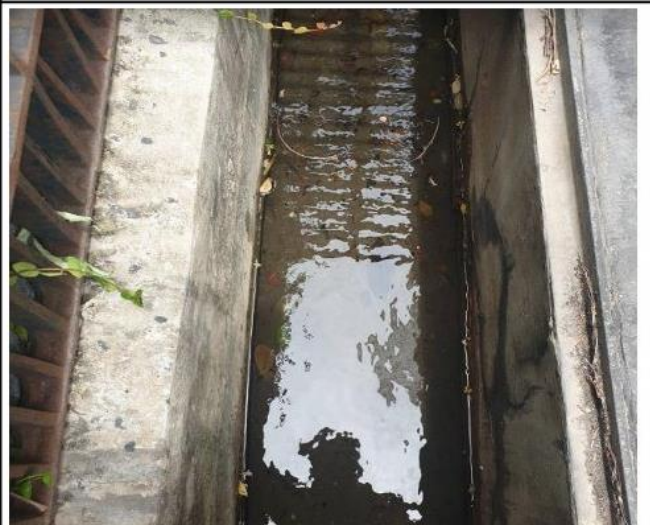
ภาพที่ 13 บ่อพักรางระบายน้ำ
