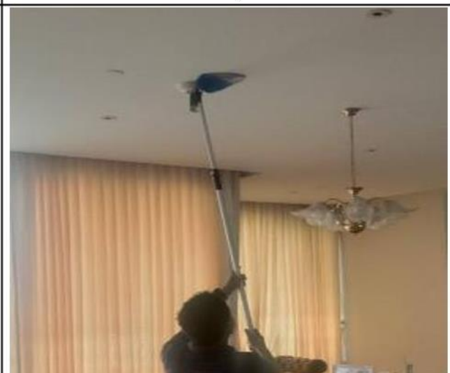
ภาพที่ 36 ตรวจเช็คระบบ Fire Alarm โดยบริษัท ดิยะ มาสเตอร์ ปีละ 3 ครั้ง
