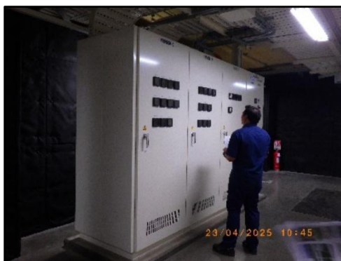
รูปที่ 2.12 ติดตั้งมิเตอร์ไฟฟ้าสำหรับระบบบำบัดน้ำเสีย
