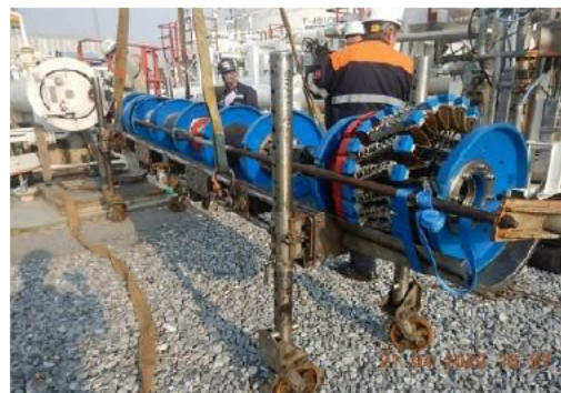
รูปที่ 2-3 การส่ง Intelligent Pig เพื่อตรวจสอบท่อส่งน้ำมัน
