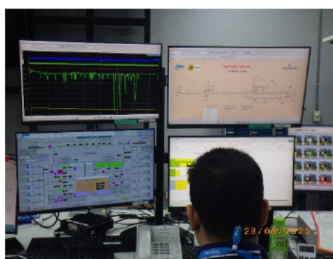
รูปที่ 2-7 การควบคุมท่อส่งน้ำมันด้วยระบบ Supervisory Control and Data Acquisition (SCADA)
