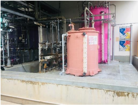
Concrete Curbing และ Floor Drain ของระบบผลิตน้ำ ชุดที่ 1
