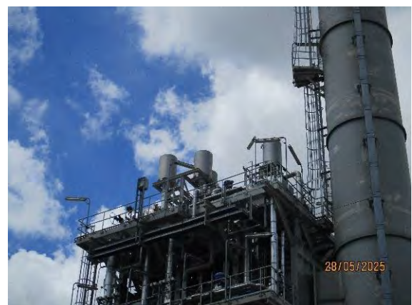
ภาพที่ 2-4 อุปกรณ์ช่วยในการลดเสียง (Silencer)
