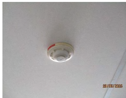
ภาพที่ 2-32 อุปกรณ์ตรวจจับความร้อน (Heat Detector)
