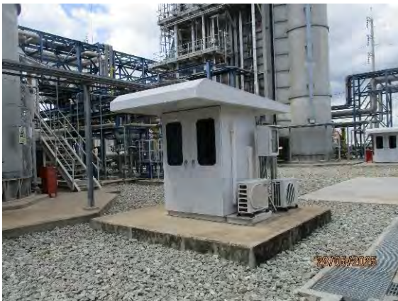
ภาพที่ 2-2 ระบบตรวจสอบคุณภาพอากาศจากปล่องระบายอากาศแบบต่อเนื่อง (CEMs)
