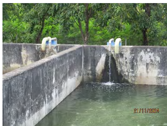
ระบบกระจายน้ำบริเวณบ่อพักน้ำหล่อเย็น
