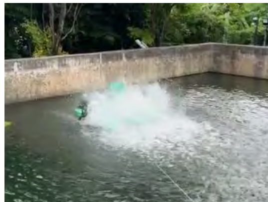
ภาพที่ 2-14 บ่อพักน้ำหล่อเย็นกรณีฉุกเฉิน
