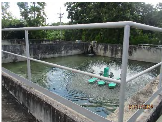
ภาพที่ 2-14 บ่อพักน้ำหล่อเย็นกรณีฉุกเฉิน
