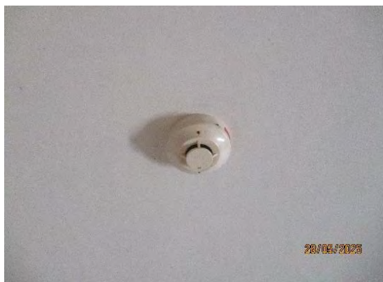
ภาพที่ 2-31 อุปกรณ์ตรวจจับควัน (Smoke Detector)
