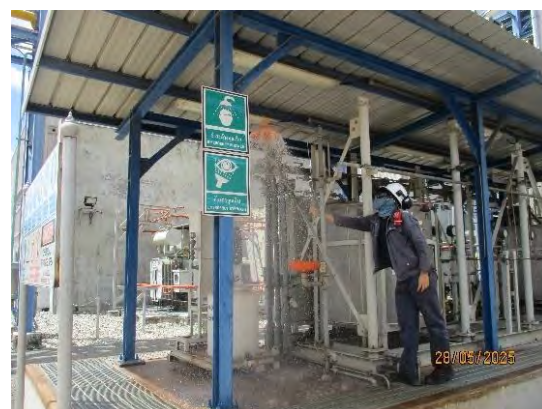
ภาพที่ 2-48 ตัวอย่างการตรวจสอบฝักบัว ชำระล้างร่างกายและดวงตา
