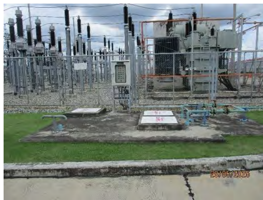
ภาพที่ 2-22 บ่อรองรับน้ำฝนปนเปื้อน
