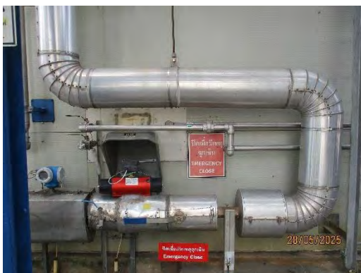
ระบบควบคุมการ Shutdown
