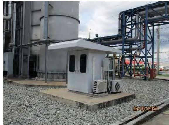
ภาพที่ 2-2 ระบบตรวจสอบคุณภาพอากาศจากปล่องระบายอากาศแบบต่อเนื่อง (CEMs)
