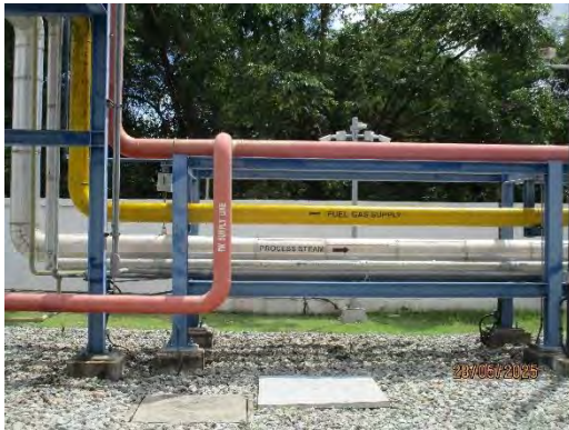
ภาพที่ 2-36 ท่อส่งก๊าซธรรมชาติที่ติดตั้งบนชั้นวางท่อ (Pipe Rack) และข้อความบ่งชี้บนท่อส่งก๊าซธรรมชาติ
