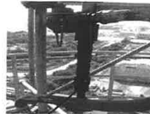
รูปที่ 4-7 ตัวอย่าง Orifice ที่ต้องทำการถอดล้าง
