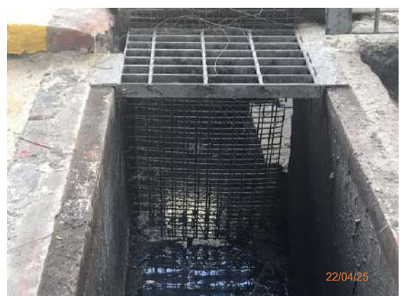
รูปที่ 2-31 ตะแกรงดักขยะ
