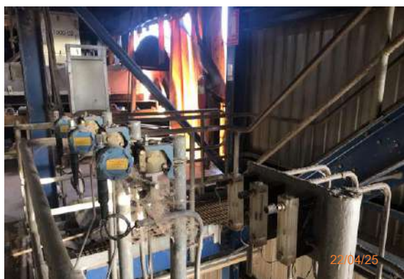
สวิตช์ควบคุมความดันหม้อไอน้ำ
