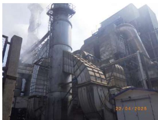
Block 2 (ระบบดักฝุ่นแบบ Wet scrubber)
