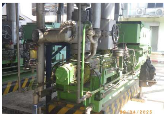
เครื่องสูบน้ำป้อนหม้อไอน้ำ
