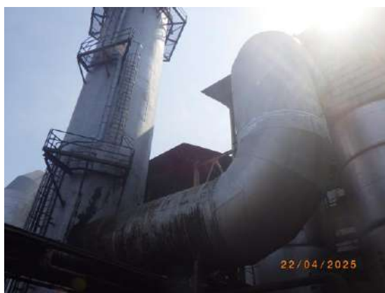
Block 3 (ระบบดักฝุ่นแบบ multicyclone ต่ออนุกรมกับ Wet scrubber)
