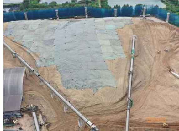
รูปที่ 2-13 การปิดคลุมกองเชื้อเพลิง
