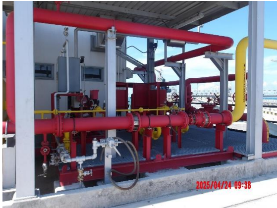
รูปที่ 2-14 การติดตั้งเครื่องฉีดน้ำและโฟมดับเพลิง บริเวณท่าเทียบเรือ
