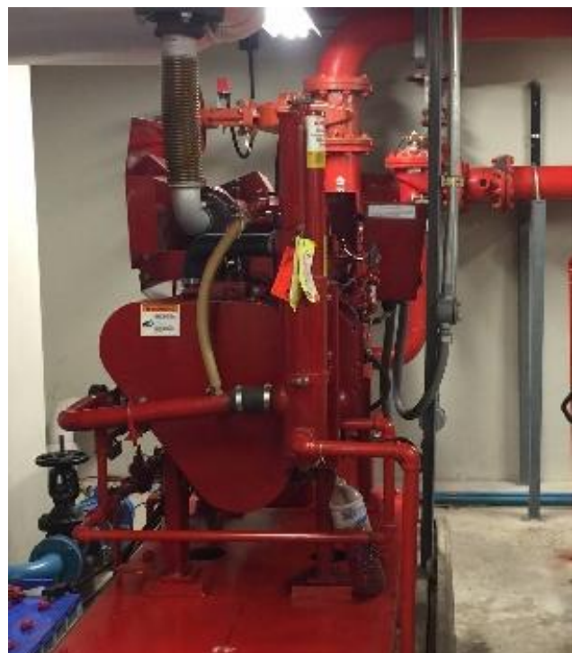
รูปที่ 22 โครงการมีเครื่องสูบน้ำดับเพลิง (Fire Pump)
