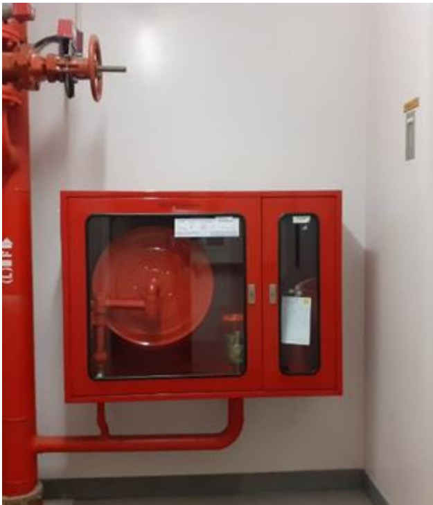
รูปที่ 19 และ 20 สายฉีดน้ำดับเพลิงและตู้เก็บสายฉีดอยู่ในสภาพพร้อมใช้งาน ป่อเก็บน้ำพร้อมใช้งานหากเกิดเหตุฉุกเฉิน
