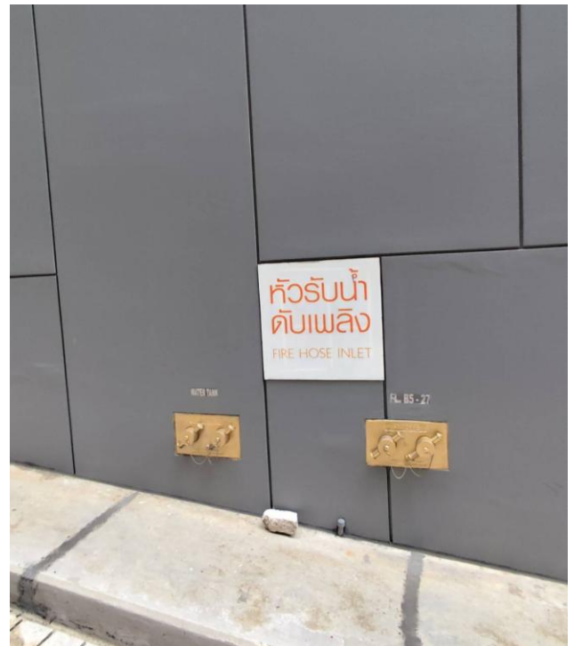
รูปที่ 18 หัวรับน้ำดับเพลิงภายในโครงการ
