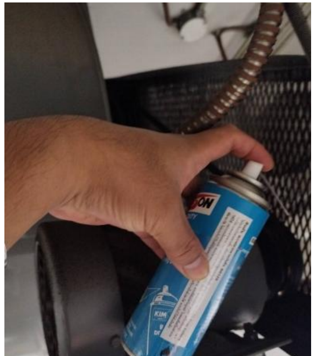
ทีมช่างอาคารดำเนินการปรับตั้งสายพาน และฉีดสเปรย์บำรุงสายพานของพัดลมดูดอากาศ บริเวณห้อง MDB
