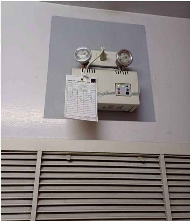
รูปที่ 15 ได้ติดตั้งไฟสำรองฉุกเฉินภายในอาคารทุกชั้น
