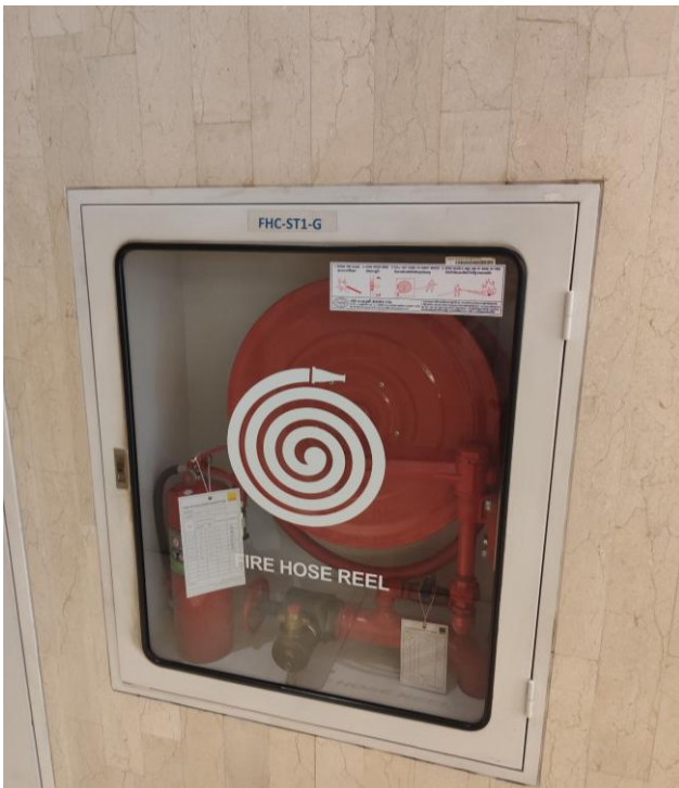
รูปที่ 17 ตู้อุปกรณ์ดับเพลิงมีอุปกรณ์ครบพร้อมใช้งาน
