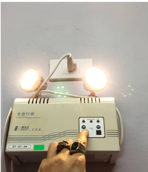
รูปที่ 37 โครงการได้จัดให้มีเจ้าหน้าที่ดูแลระบบไฟฉุกเฉินภายในอาคารเป็นประจำ เดือนละ 1 ครั้ง
