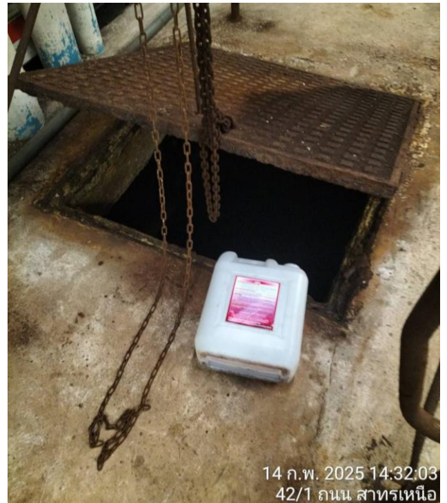
รูปที่ 10 ช่างอาคารดำเนินการเติมจุลินทรีย์บำบัดน้ำเสียเป็นประจำทุกเดือน
