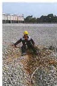
Block 1 อาคารเก็บก๊าซ N 2 &Co 2 ขณะทำการติดตั้ง ดอกแท่งกรวดทองแดง สายล่อฟ้า
