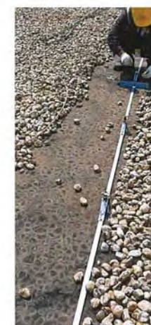
Block 1 อาคารเก็บก๊าซ N 2 &Co 2 ขณะทำการติดตั้ง Support ยึดสายทองแดง เปลี่ยน 50 Sqmm.
