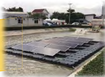
ภาพตัวอย่างของ ระบบผลิตไฟฟ้าจากพลังงาน แสงอาทิตย์แบบลอยน้ำ
