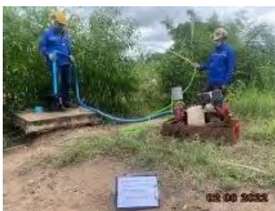
สูบน้ำออกจากบ่อ
