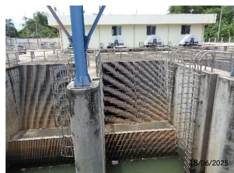
รูปที่ 2.2-19 ตะแกรงช่องรับน้ำ บริเวณสถานีสูบน้ำท่าราช
