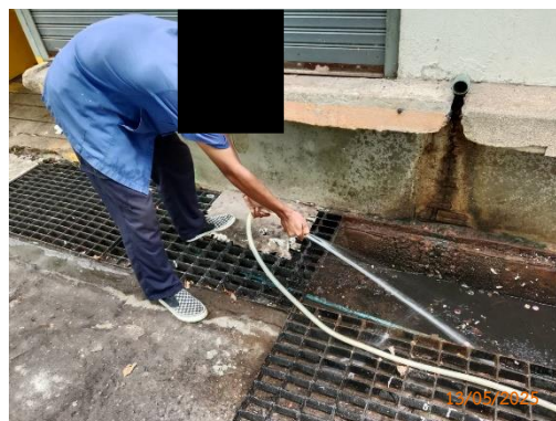
รูปที่ 2-10 การลอกท่อระบายน้ำ
