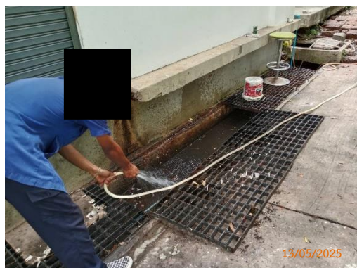
รูปที่ 2-10 การลอกท่อระบายน้ำ
