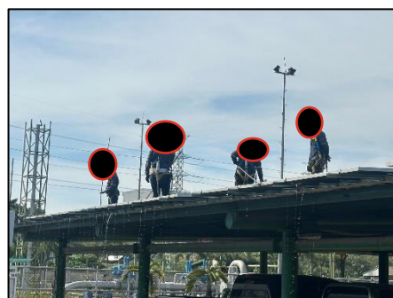
ภาพที่ 2.1-20 การล้างทำความสะอาดแผงโฟโตโวลเทอิกและพนักงานสวมใส่อุปกรณ์ป้องกันอันตรายส่วนบุคคล
