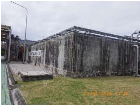
รูปที่ 2-33 บ่อน้ำสำรองขนาด 1,200 ลูกบาศก์เมตร
