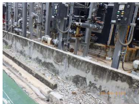
รูปที่ 2-38 คันกัน (Dike) คอนกรีตล้อมรอบบริเวณถังเก็บ สารเคมี
