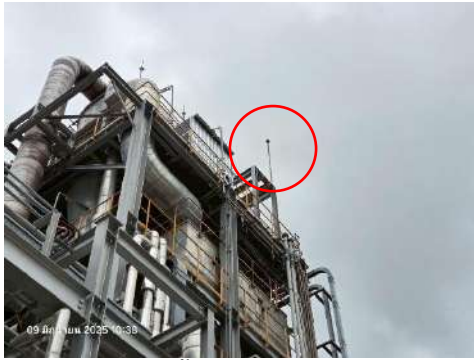
รูปที่ 2-52 ติดตั้งสายล่อฟ้าตามมาตรฐาน
