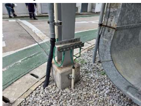
รูปที่ 2-51 ติดตั้งสายกราวด์ลงดินตามมาตรฐาน
