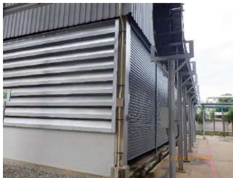
รูปที่ 2-56 อาคารควบคุมเสียงจากเครื่องจักร
