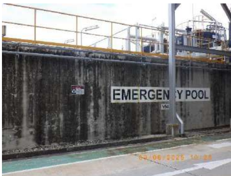
บ่อพักน้ำฉุกเฉินขนาด 1,500 ลูกบาศก์เมตร
