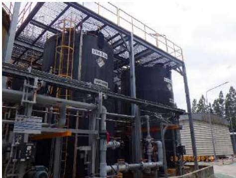
รูปที่ 2-11 HCl Storage Tank
