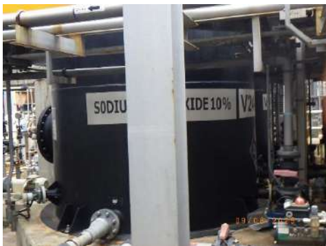
รูปที่ 2-5 ถังสารละลาย NaOH 10% ที่มีการสำรอง
