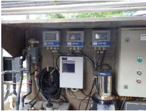
รูปที่ 2-14 เครื่องมือวิเคราะห์อย่างต่อเนื่อง (Online-Analyzer)
