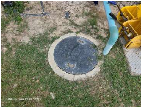
รูปที่ 2-26 ระบบบำบัดน้ำเสียสำเร็จรูป (Septic Tank)
