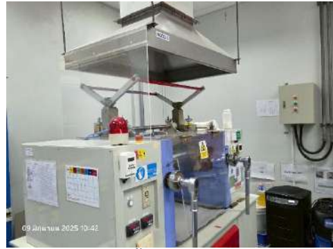
รูปที่ 2-53 ภาพการติดตั้งระบบป้องกันไอสารเคมี (Filter)
