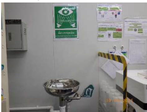
รูปที่ 2-37 อ่างล้างตาและร่างกายในกรณีฉุกเฉิน
