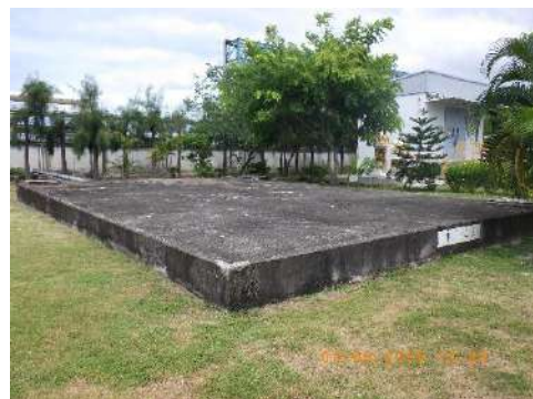
บ่อพักน้ำฉุกเฉินขนาด 160 ลูกบาศก์เมตร
