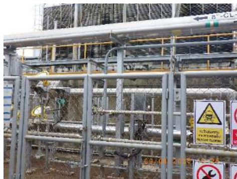
รูปที่ 2-44 การปิดกั้นพื้นที่ตลอดแนวการวางท่อ
