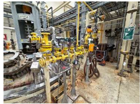
รูปที่ 2-41 อุปกรณ์ตรวจสอบและป้องกันการรั่วไหลของก๊าซคลอรีน
