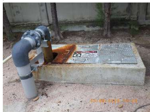
รูปที่ 2-8 ถังรวบรวมน้ำเสีย (Waste Water Inspection Pit (V89-N))
