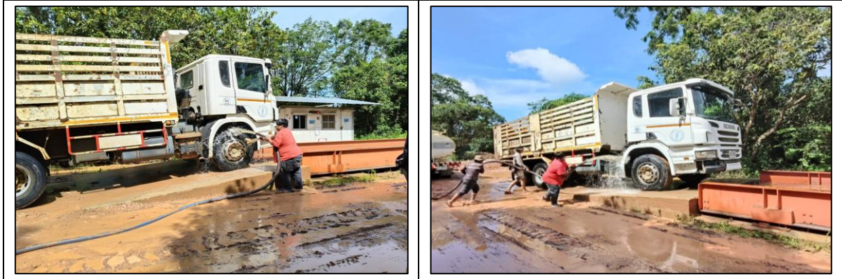
รูปที่ 3.1-27 การล้างทำความสะอาดล้อในพื้นที่โครงการ
