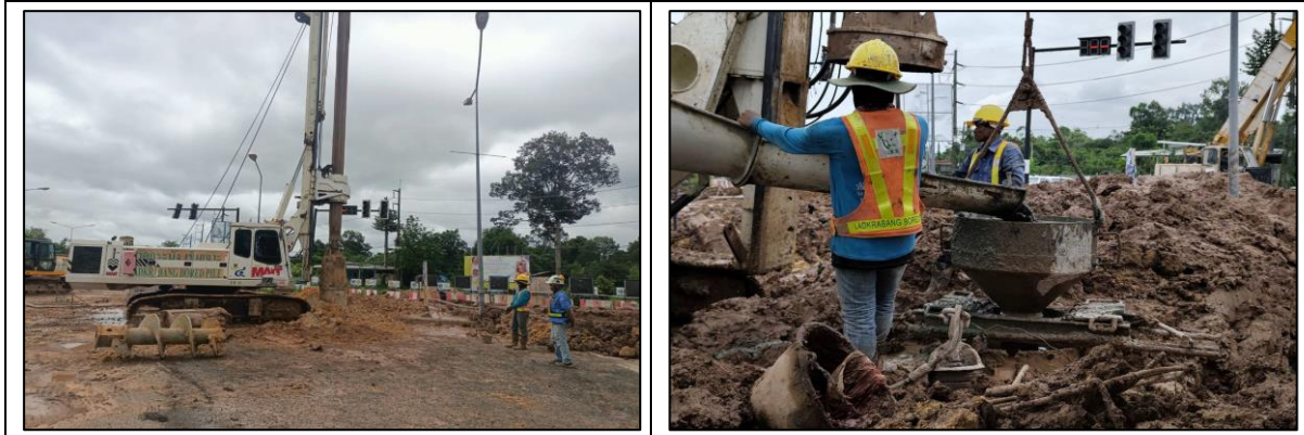
รูปที่ 3.1-13 การก่อสร้างตอม่อโดยใช้เสาเข็มแบบเจาะ
