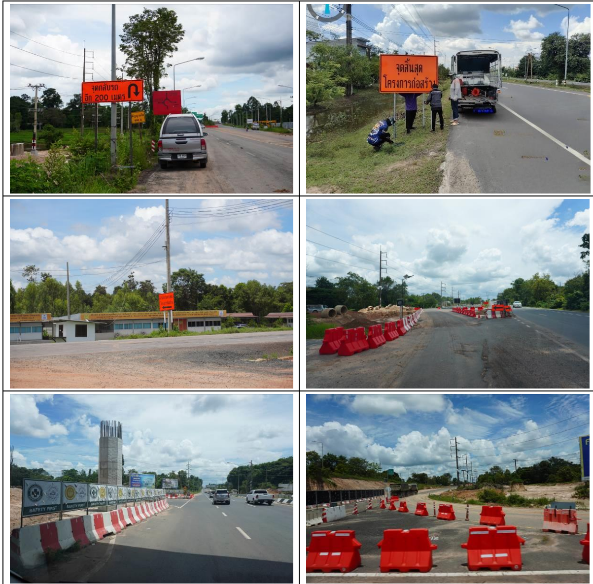
รูปที่ 3.1-8 การติดตั้งป้ายป้ายจราจรต่าง ๆ และการเบี่ยงจราจร (ต่อ)
