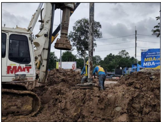
รูปที่ 2.3-4 กิจกรรมงานเสาเข็มเจาะช่วงแยกกุดลาด
