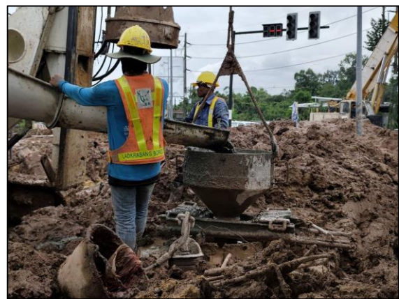
รูปที่ 2.3-4 กิจกรรมงานเสาเข็มเจาะช่วงแยกกุดลาด
