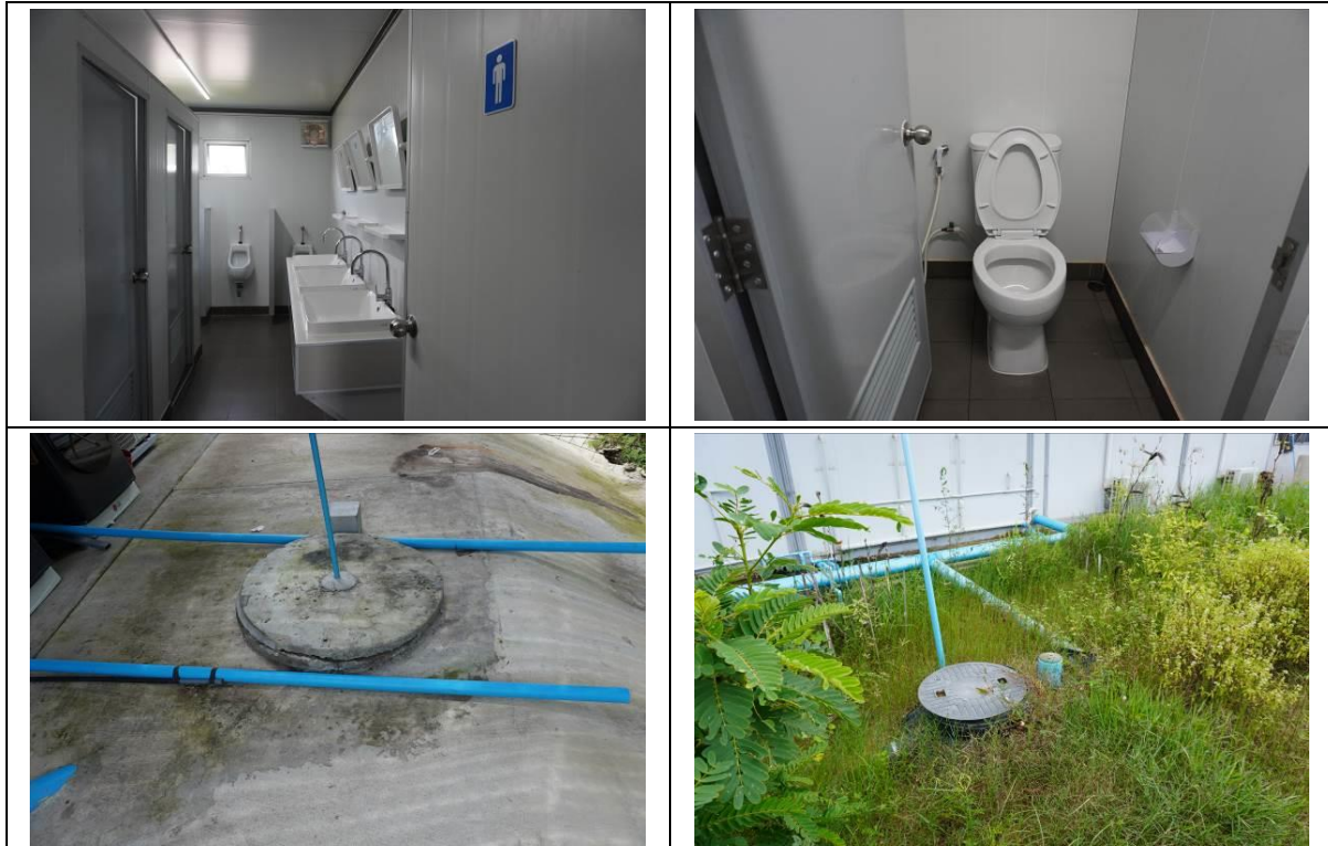
รูปที่ 3.1-6 ห้องน้ำ และการติดตั้งบ่อเกรอะ-บ่อซึม และถังบำบัดน้ำเสียสำเร็จรูป บริเวณสำนักงานโครงการและที่พักคนงาน
