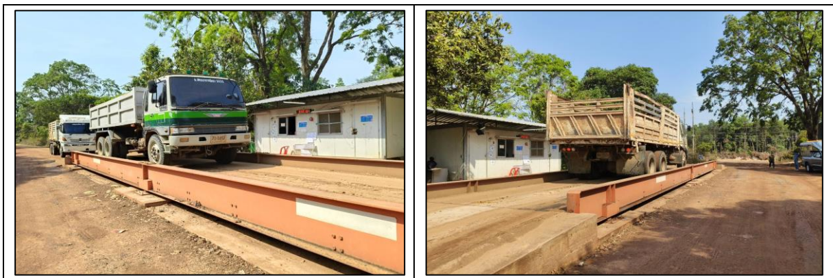
รูปที่ 3.1-28 การชั่งน้ำหนักรถบรรทุกก่อนเข้าพื้นที่โครงการ
