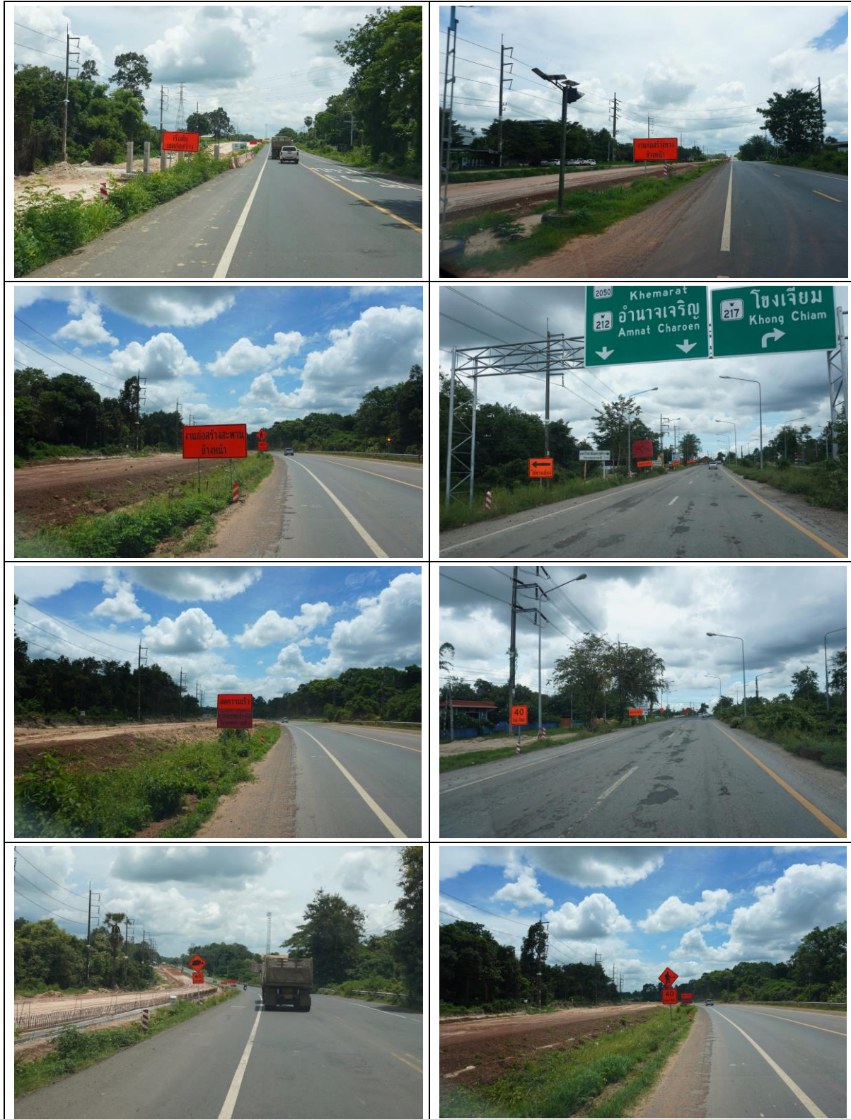
รูปที่ 3.1-8 การติดตั้งป้ายป้ายจราจรต่าง ๆ และการเบี่ยงจราจร
