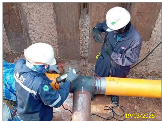
กิจกรรมการตรวจสอบรอยเชื่อมด้วยวิธีที่ไม่ทำลายสภาพ (NDT)
