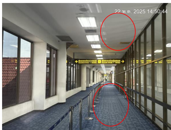
รูปที่ 19 บริเวณอาคารผู้โดยสารส่วนที่ติดกับลานจอดอากาศยาน มีการติดตั้งกระจก 2 ชั้น ปูพรม และติดตั้งเพดานยิปซัมบอร์ด เพื่อดูดซับเสียง
