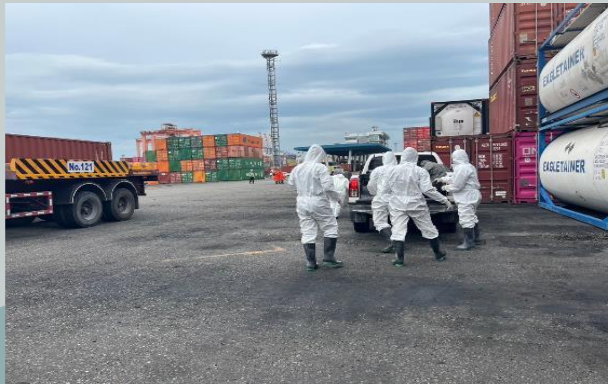
10. ทีมสิ่งแวดล้อม HPT เตรียมทราย/ จี้เลื่อย/ วัสดุดูดซับสารเคมีที่หกแล้วไหล และติดต่อบริษัทตรวจวัดสิ่งแวดล้อม เพื่อเข้ามาตรวจวัดคุณภาพอากาศในพื้นที่เกิดเหตุ
