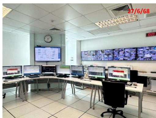
ภาพที่ 2.2-5 ศูนย์ควบคุมฉุกเฉิน (SCADA ROOM)
