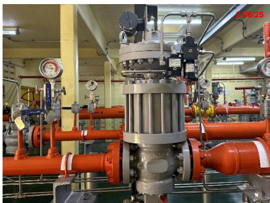
ภาพที่ 2.2-5 วาล์วควบคุมแรงดัน บริเวณสถานีก๊าซฯ OTS
