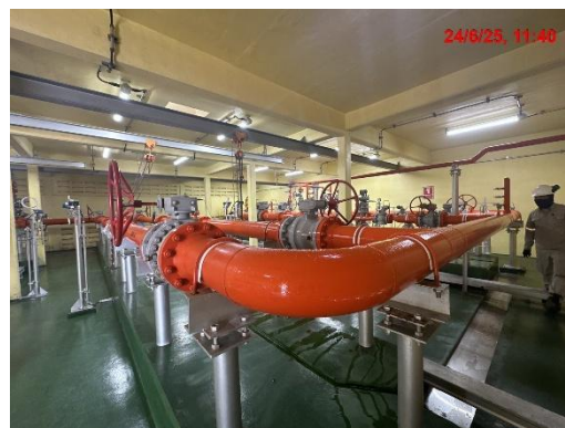
ภาพที่ 2.2-5 วาล์วควบคุมแรงดัน บริเวณสถานีก๊าซฯ OTS
