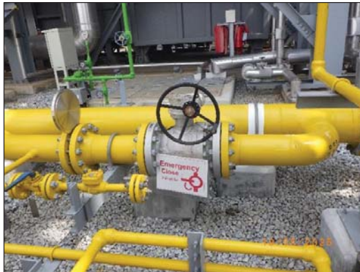
รูปที่ 2-31 อุปกรณ์วาล์วตัดแยกระบบ (Manual Isolation Valve)
