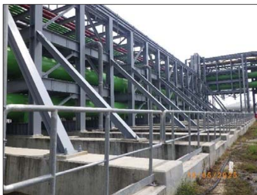
รูปที่ 2-10 ปอพักน้ำทิ้งฉุกเฉิน (Emergency Pit)
