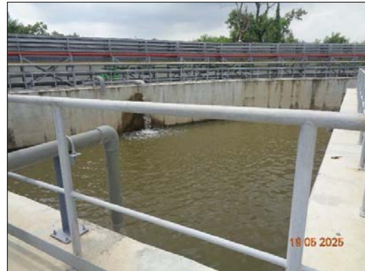
รูปที่ 2-8 ปอพักน้ำทิ้ง (Retention Pit)
