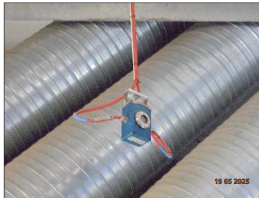
ระบบตรวจจับแสงและประกายไฟ
