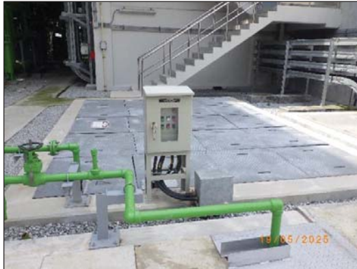
รูปที่ 2-7 ปอแยกน้ำ-น้ำมัน (Oil Water Separator)
