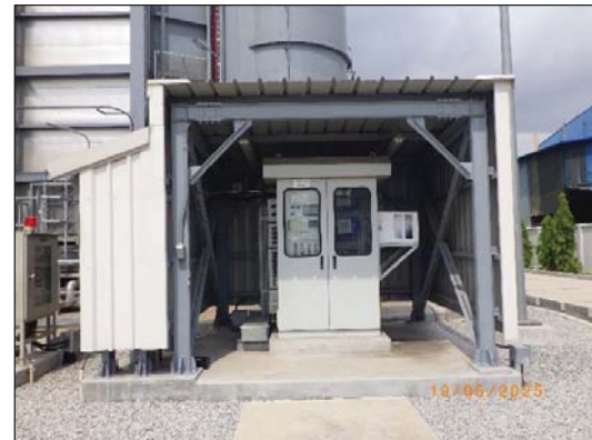
รูปที่ 2-4 เครื่องตรวจวัดคุณภาพอากาศ แบบต่อเนื่อง (CEMs)
