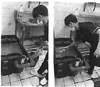
ภาพประกอบที่ 1 ทีมงานแม่ครัวที่ดูแลโรงงาน ทำการดักไขมันที่บ่อดักไขมันบน
