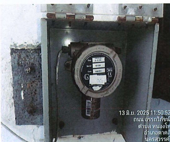
ภาพที่ 19 เครื่องตรวจการรั่วไหล \text{ClO}_2
