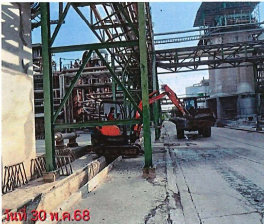
ภาพที่ 8 การขุดลอกร่องระบายน้ำฝน
