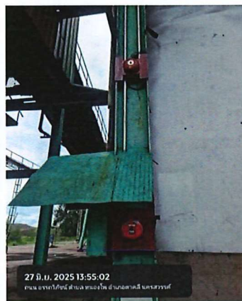
ภาพที่ 18 สัญญาณเตือนแบบธรรมดาและอัตโนมัติ
