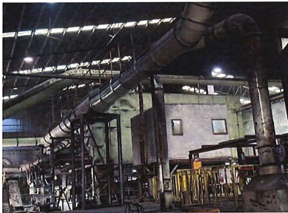
ภาพที่ 15 ระบบดูดอากาศ (ป้องกันการฟุ้งกระจายของฝุ่นทราย)
