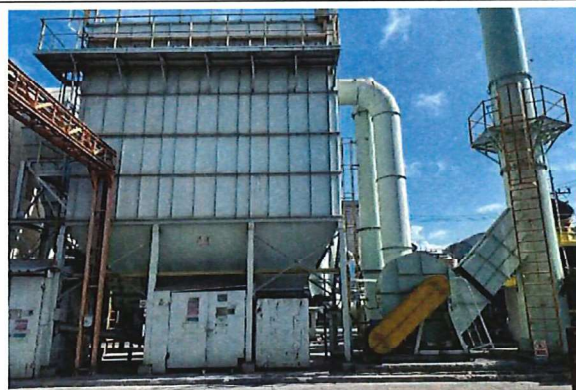
ภาพที่ 6 ปล่องระบบดักฝุ่นจาก Melting furnace No.1&2 (Line ACE)
