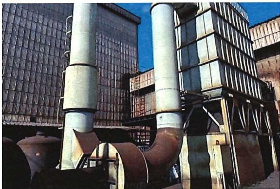
ภาพที่ 3 ปล่องระบบดักฝุ่นจาก Finishing & Grinding (Line ACE)
