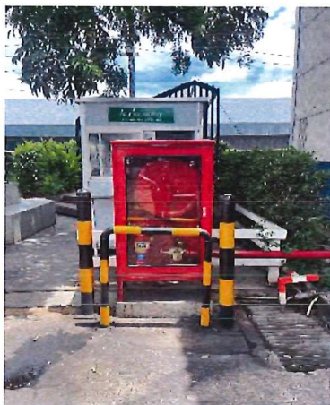
ภาพที่ 59 ท่อเย็นและตู้สายฉีดน้ำดับเพลิง
