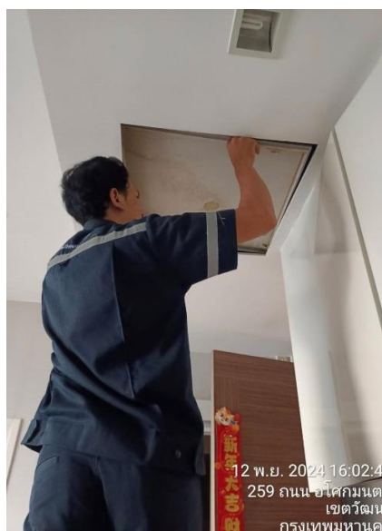
รูปภาพที่ 74 บุฉนวนเพดานเพื่อลดพื้นที่ในการ ใช้ระบบปรับอากาศ
