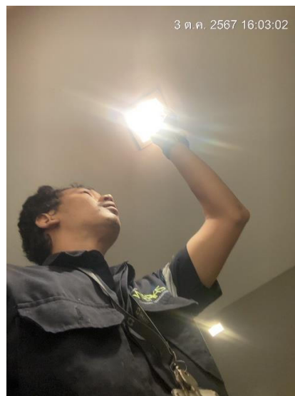
รูปภาพที่ 80 เปลี่ยนหลอดที่ใช้บัลลาสต์ เป็นหลอด แอลอีดี
