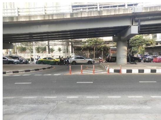
รูปภาพที่ 120 ติดตั้งหลักสะท้อนแสง จุดกลับรถ หน้าโครงการ
