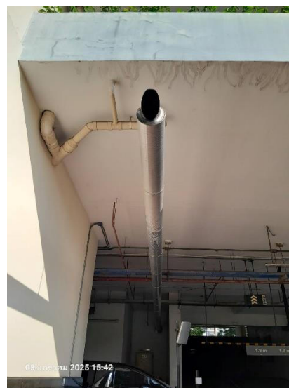
รูปภาพที่ 67 ระบบท่อระบายไอเสีย เครื่องกำเนิดไฟฟ้าสำรอง
