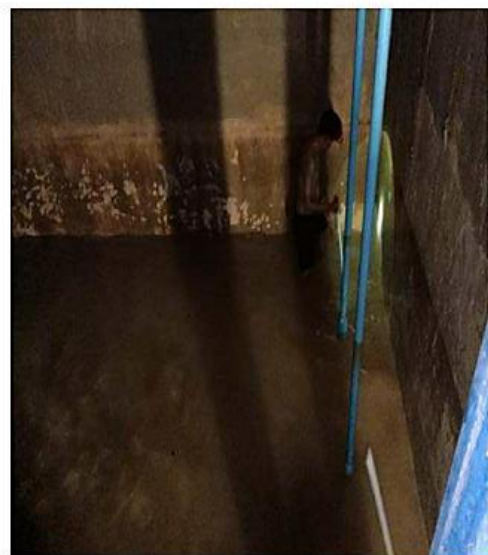
รูปภาพที่ 4 ภาพการทำความสะอาดถังเก็บน้ำดี
