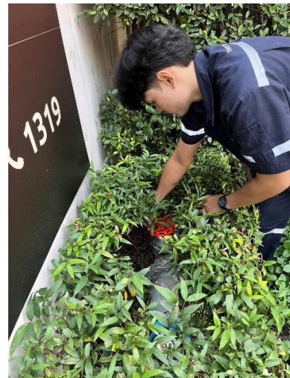
รูปภาพที่ 33 (ต่อ)การปิดวาล์วควบคุมการจ่ายน้ำ จากท่อเมนประปา ตามมาตรการ
