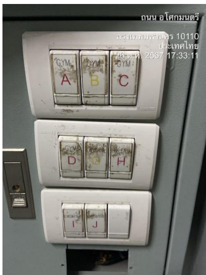
รูปภาพที่ 77 แยกสวิตช์ ระบบไฟฟ้าเพื่อลด จำนวนหลอด
