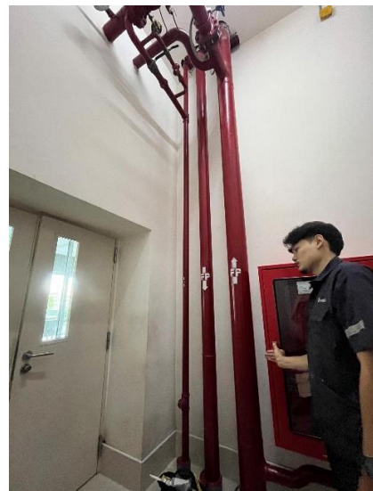
รูปภาพที่ 92 ท่อเมนดับเพลิงจ่ายชั้น 8-42
