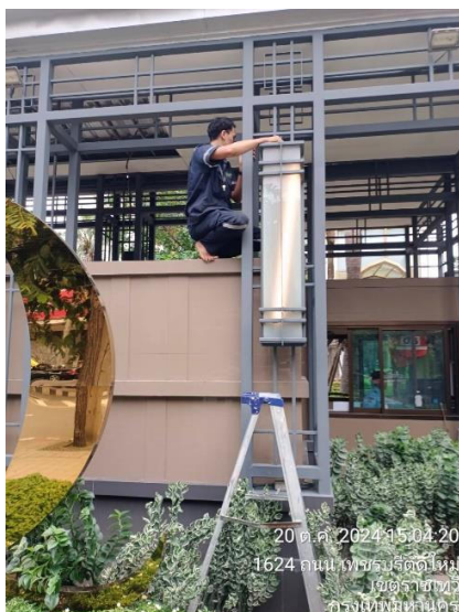
รูปภาพที่ 79 เปลี่ยนหลอดที่ใช้บัลลาสต์ เป็นหลอด แอลอีดี
