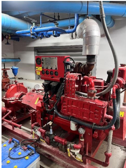
รูปภาพที่ 89 เครื่องสูบน้ำดับเพลิงดับ เครื่องยนต์ดีเซล ชั้น 8
