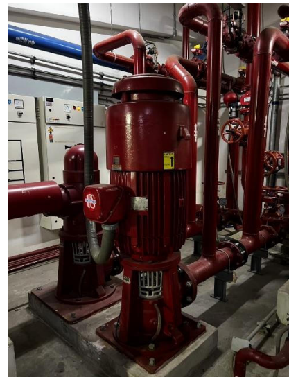
รูปภาพที่ 88 เครื่องสูบน้ำดับเพลิง แบบไฟฟ้า ชั้น 1
