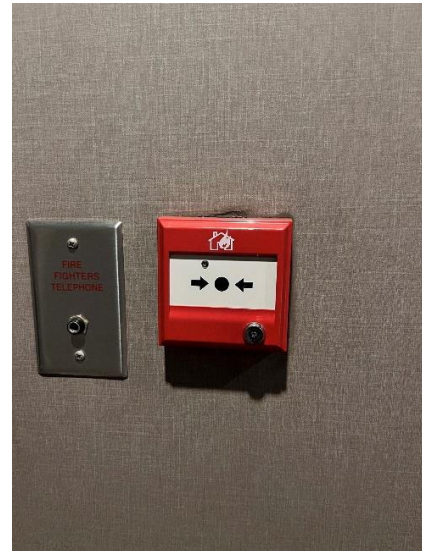
รูปภาพที่ 102 เครื่องแจ้งเหตุด้วยการใช้มือ
