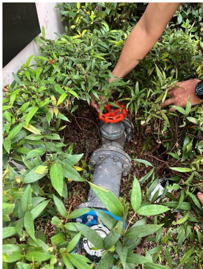
รูปภาพที่ 32 การปิดวาล์วควบคุมการจ่ายน้ำ จากท่อเมนประปา ตามมาตรการ
