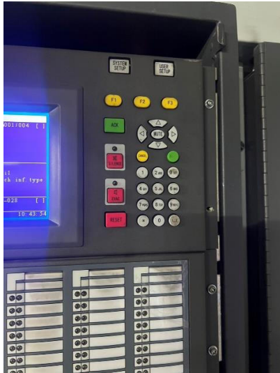
รูปภาพที่ 101 ตู้ควบคุมไฟอราม
