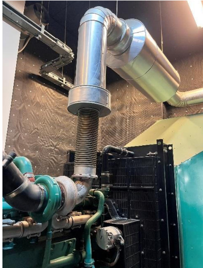
รูปภาพที่ 68 ท่อระบายไอเสีย ไม่ให้มีจุด รั่วซึม
