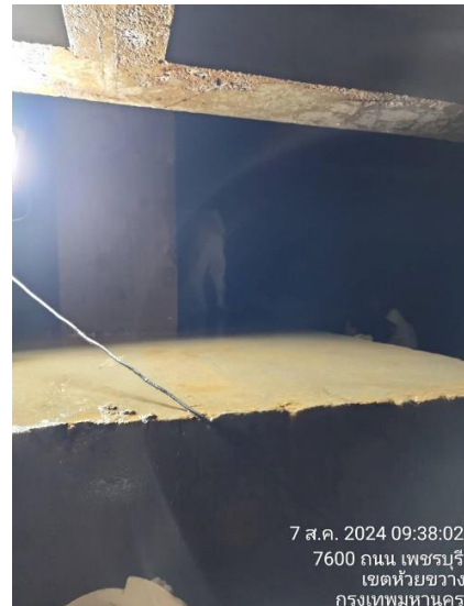
รูปภาพที่ 136 ตรวจสอบเสาคอนกรีตในถังเก็บน้ำ
